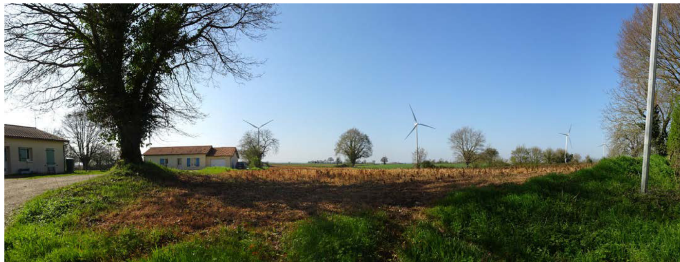
PHOTO 132 : LA ZIP S'INSCRIT ENTRE DEUX ÉOLIENNES EXISTANTES À L'ARRIÈRE PLAN - LA PRÉSENCE DU MOTIF ÉOLIEN DANS LE PAYSAGE QUOTIDIEN ATTÉNUÉ LÉGÈREMENT AINSI LA SENSIBILITÉ DU HAMEAU
