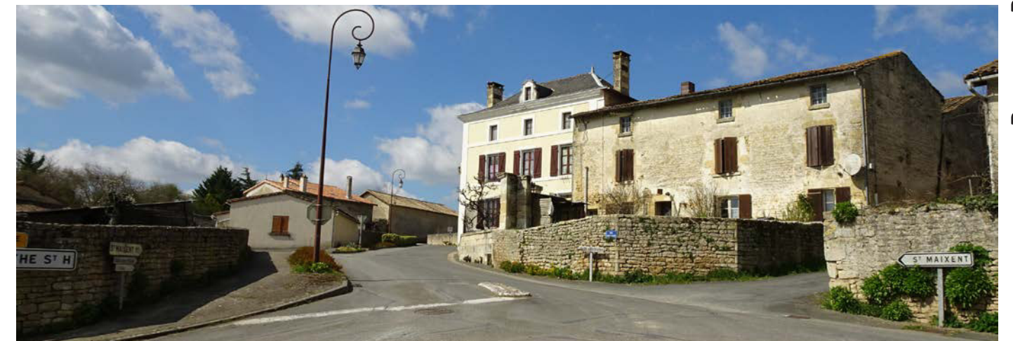
PHOTO 141 : VUE TRONQUÉE VERS LA ZIP DEPUIS LES ABORDS IMMÉDIATS DE L'ÉGLISE
